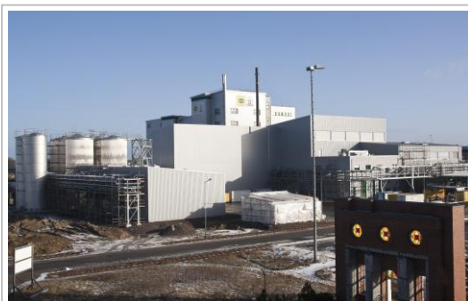
Die neue Tensidanlage nach ihrer Fertigstellung
